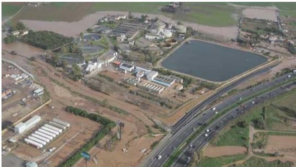
Figura 3. Imagen aérea de la central depuradora EDAR Palma I y II, afectada por inundaciones. Se aprecia la balsa donde se almacenan las aguas que usan los agricultores para regar sus cultivos.
